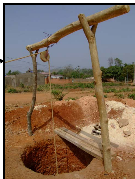
Foto. Pozo tradicional donde la cuerda toca al suelo con ganado cerca + excesivo esfuerzo de subida del cubo (Burkina Faso)
