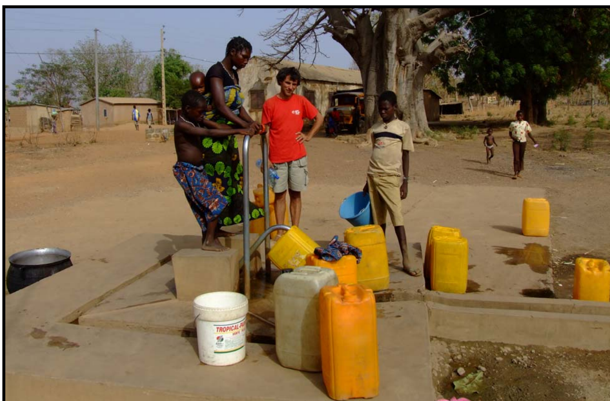
Foto: pozo con bomba de pie. Sistema de canalización del agua sobrante y losa de protección del pozo. (Benin)
