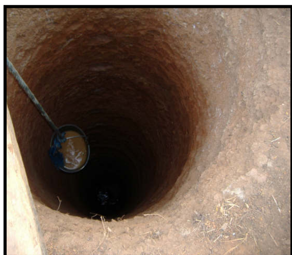
Foto: Vaciar el pozo llenando cubos de tierra (Camerún)
