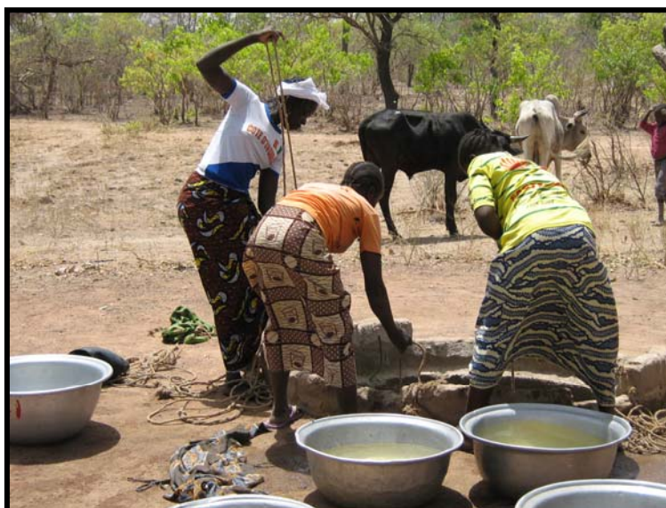
Foto. Pozo tradicional donde la cuerda toca al suelo con ganado cerca + excesivo esfuerzo de subida del cubo (Burkina Faso)
