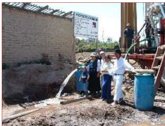
Sondeo de perforación para la captación de agua
